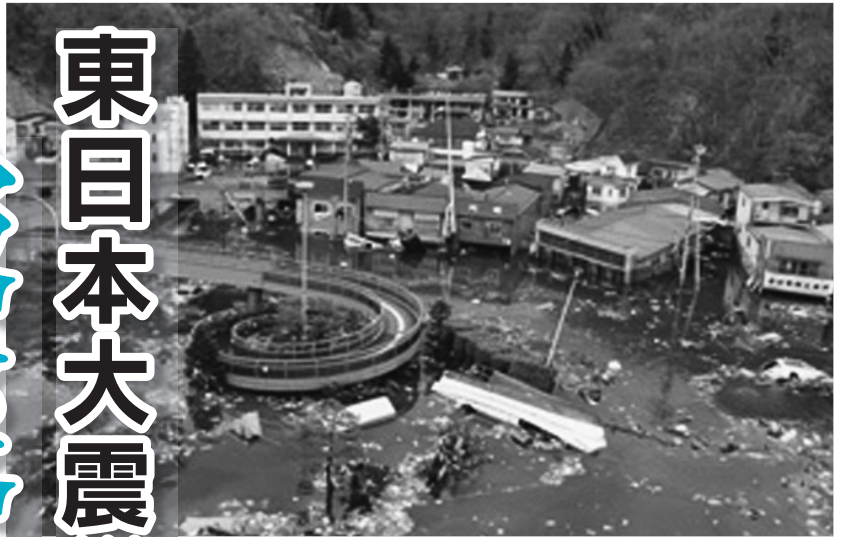
津波により浸水した旧市役所前交差点 (宮古市ホームページより)
